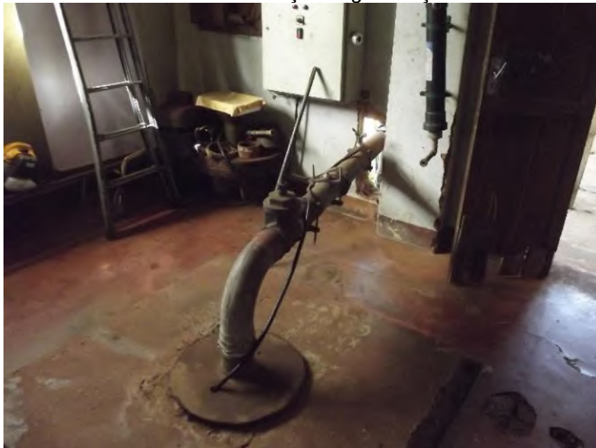
Foto 6.24 – Poço Vila Rossi
