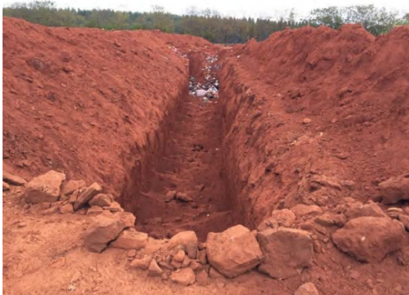
Foto 6.41. – Vista da Frente de Trabalho
