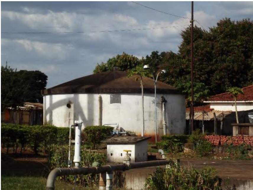
Foto 6.12 – Reservatório Jd. Bela Vista III
