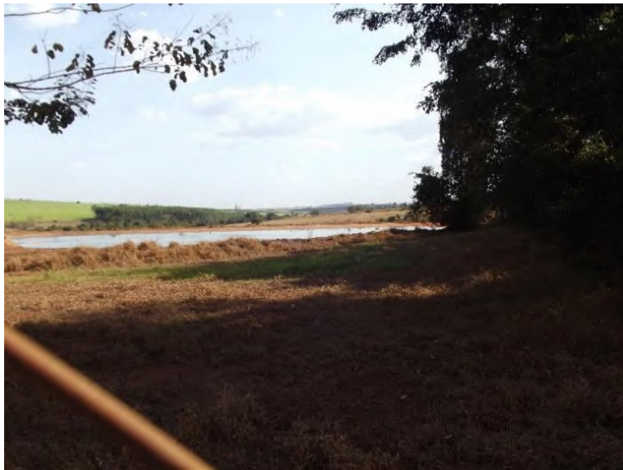
Foto 6.35 – Lagoa Anaeróbica da Estação de Tratamento
