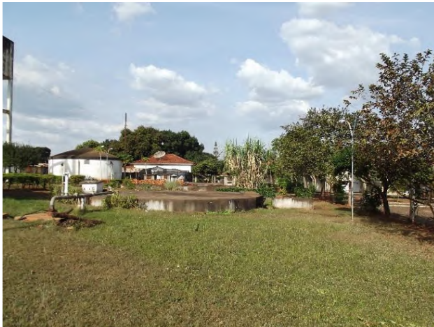
Foto 6.10 – Reservatório Jd. Bela Vista I
