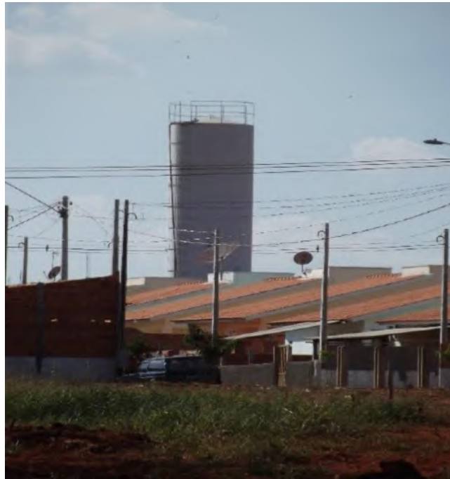
Foto 6.5 – Reservatório Jd. Santa Elisa
