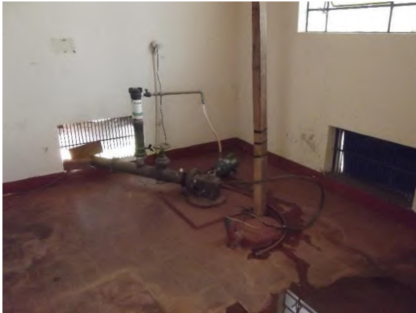
Foto 6.23 – Poço Antiga Estação
